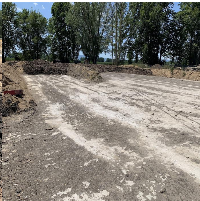
ΣΩΡΟΙ ΥΛΙΚΟΥ ΑΝΑΡΧΑ ΤΟΠΟΘΕΤΗΜΕΝΟΙ ΧΩΡΙΣ ΕΛΕΓΧΟ ΠΑΡΑΜΕΤΡΩΝ ΚΑΙ ΕΠΟΠΤΕΙΑ ΠΕΡΙΜΕΤΡΙΚΑ ΤΗΣ ΤΣΙΜΕΝΤΕΝΙΑΣ ΠΙΣΤΑΣ ΚΑΙ ΧΩΡΙΣ ΠΡΟΔΙΑΓΡΑΦΕΣ ΠΡΟΣΤΑΣΙΑΣ ΤΟΥ ΠΕΡΙΒΑΛΛΟΝΤΟΣ
