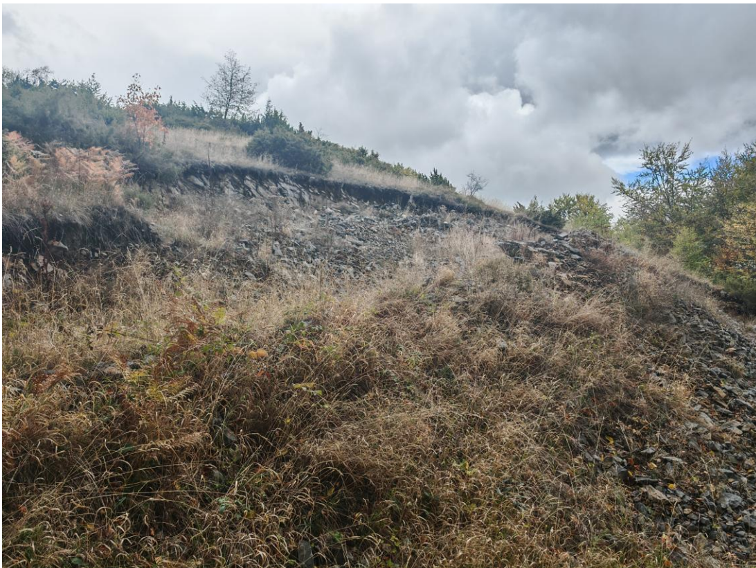
Φωτ. 2: Ανώτερη εκσκαφή στα πλαίσια διαμόρφωσης του λατομικού χώρου
