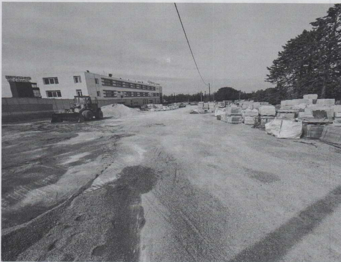
Εικόνα 7: Άποψη της νέας εγκατάστασης της εταιρείας στην θέση Λυγαριά στην εκτός σχεδίου περιοχή Πυλαίας Θεσσαλονίκης
