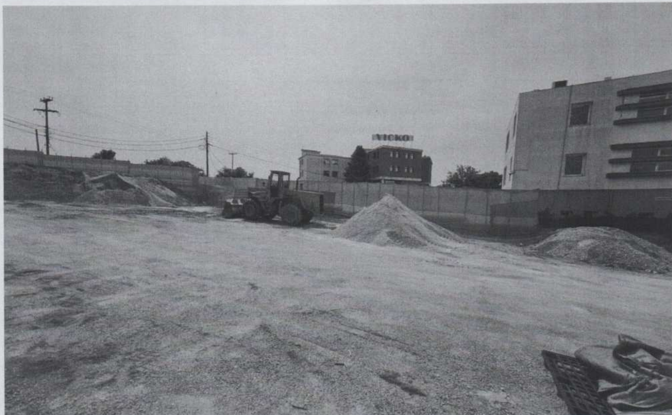
Εικόνα 6: Άποψη της νέας εγκατάστασης της εταιρείας στην θέση Λυγαριά στην εκτός σχεδίου περιοχή Πυλαίας Θεσσαλονίκης
