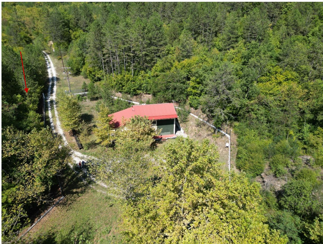
Εικόνα 1: Δρόμος πρόσβασης και κτίριο σταθμού
