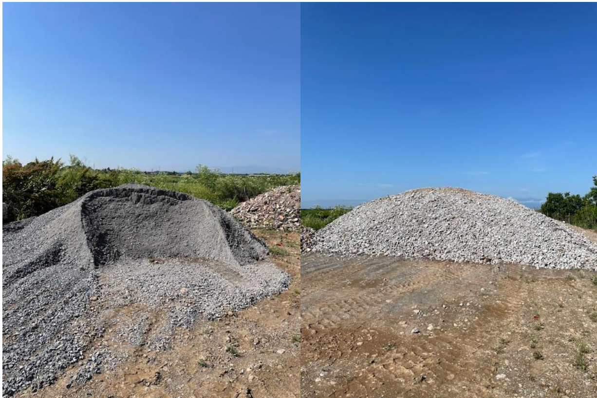
Φωτογραφία 7. Θρυμμένο σκυρόδεμα μετά την επεξεργασία
