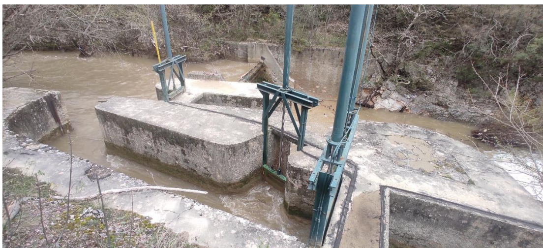
Εικόνα 6: Υφιστάμενα θυροφράγματα
