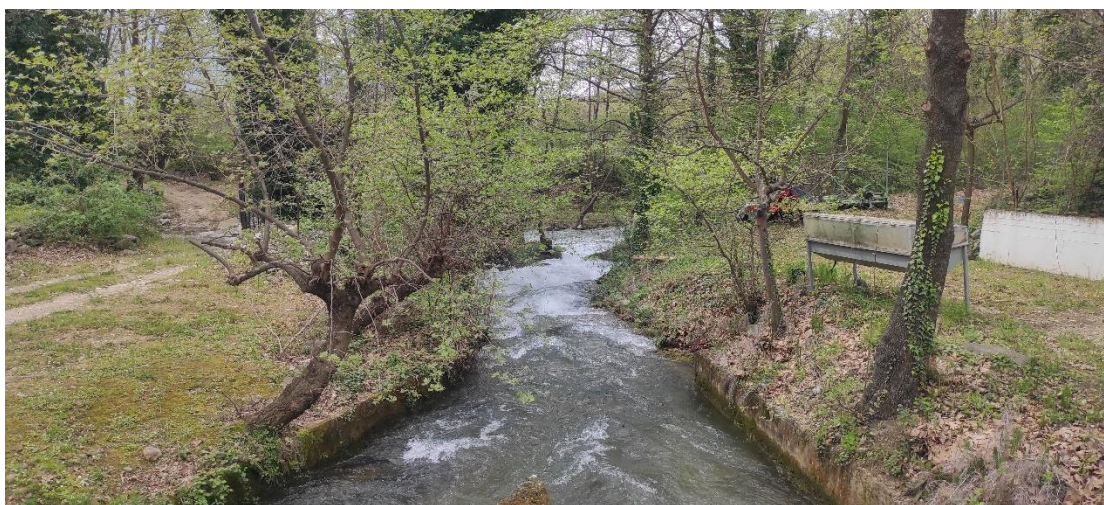
Εικόνα 5: Διώρυγα φυγής νερού προς τη φυσική κοίτη του ρέματος
