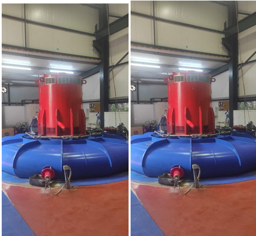
Εικόνα 3: Στροβιλογεννήτριες. Οι γεννήτριες είναι σύγχρονες, τριφασικές, αερόψυκτες, κάθετου άξονα, και συνδέονται κατευθείαν στο στροφείο του στροβίλου
