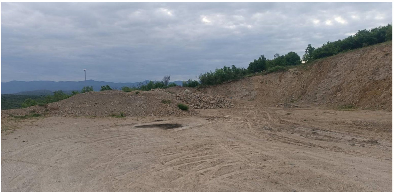
ΦΩΤΟ 2: Γενική άποψη τμήματος της υπό διαμόρφωση πλατείας, στα χαμηλότερα υψόμετρα του λατομικού χώρου. Διακρίνεται τμήμα του πρανούς της εκσκαφής, καθώς και τα υλικά που προκύπτουν από τις λατομικές εργασίες. Στο βάθος δεξιά διακρίνεται η κάμερα 24ωρης παρατήρησης, για λόγους ασφάλειας.
