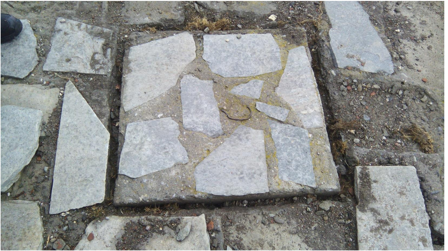
Φωτογραφία 5: Άποψη της στεγανής δεξαμενής του συστήματος του Σαλέ της κορυφής στη θέση “Βουλγάρα”
